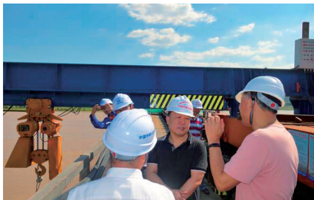
2019年7月16日，西安铁路监管局检查新建银川至西安铁路工程（陕西段）黄河特大桥改建工程（西安铁路监管局）
