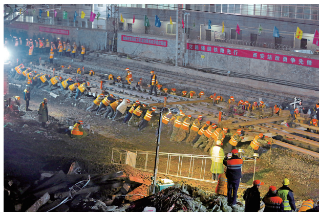
2019 年 1 月 15 日，西安站改东岔区扩建工程首次连锁设备换装施工圆满完成，标志着西安站改扩建工程正式进入主体工程施工阶段（中铁西安局集团）
