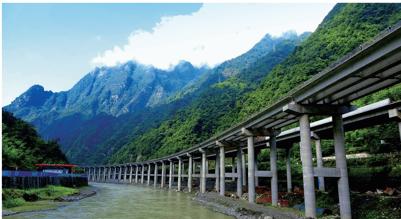
2019年10月30日，安岚高速湘子坝特大桥右幅顺利贯通，全长4401米（省高速集团）
