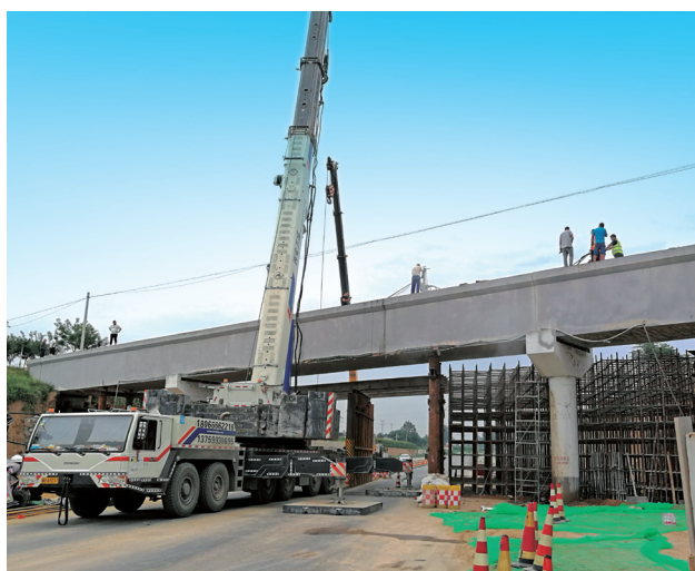
2019 年 8 月 31 日，108 国道咸阳境内渡槽施工现场
