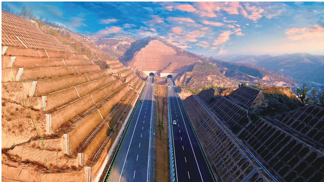
2019年10月26日，建设中的绥德至延川高速公路及赤土沟隧道
