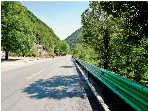
212 省道陇风线，属危险化学品运输通道，2019 年新设钢板护栏 (省公路局)
