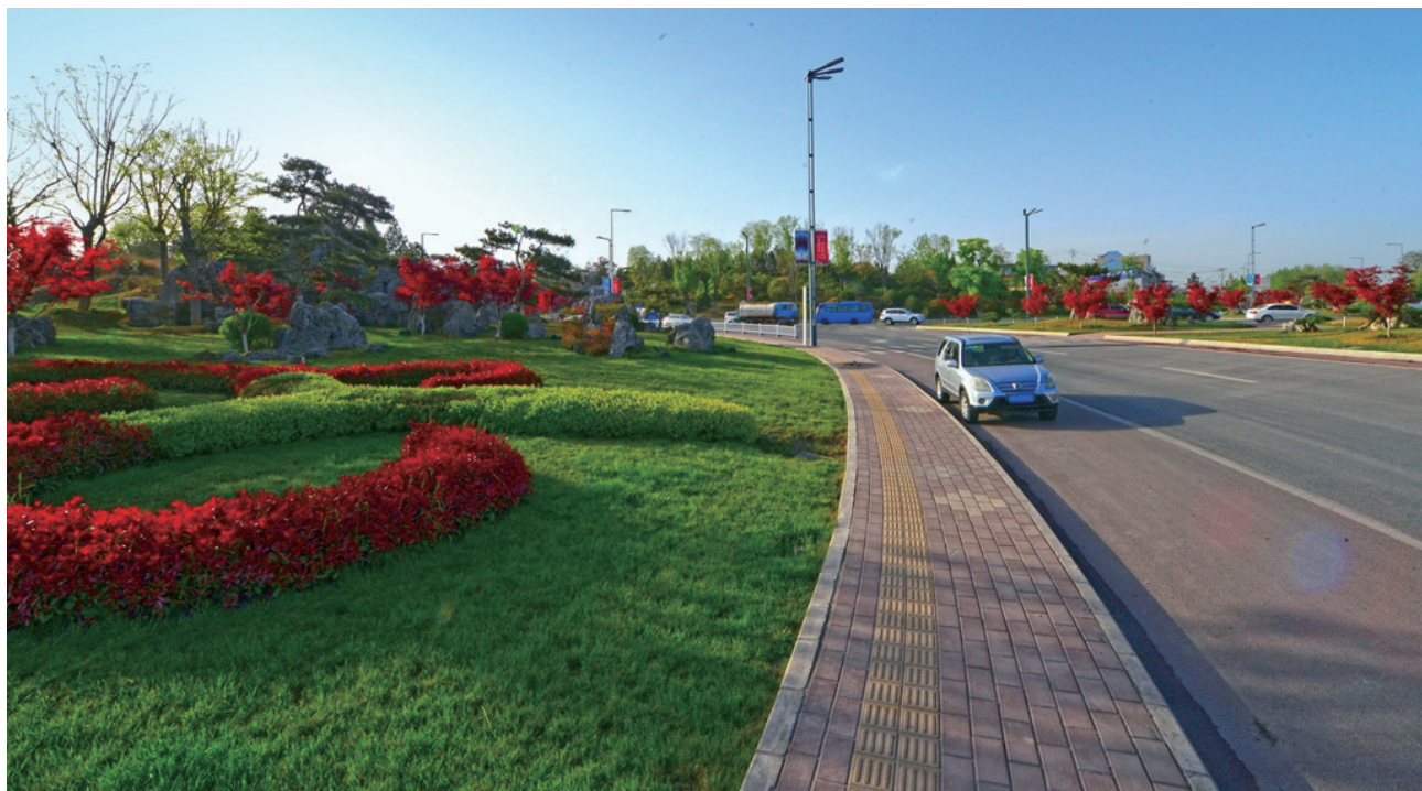
2019 年 5 月，210 国道川口至青岗岭段整治完工
