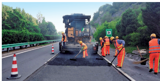
2019年6月18日，西延高速路面中面层养护施工现场 (省高速集团)
