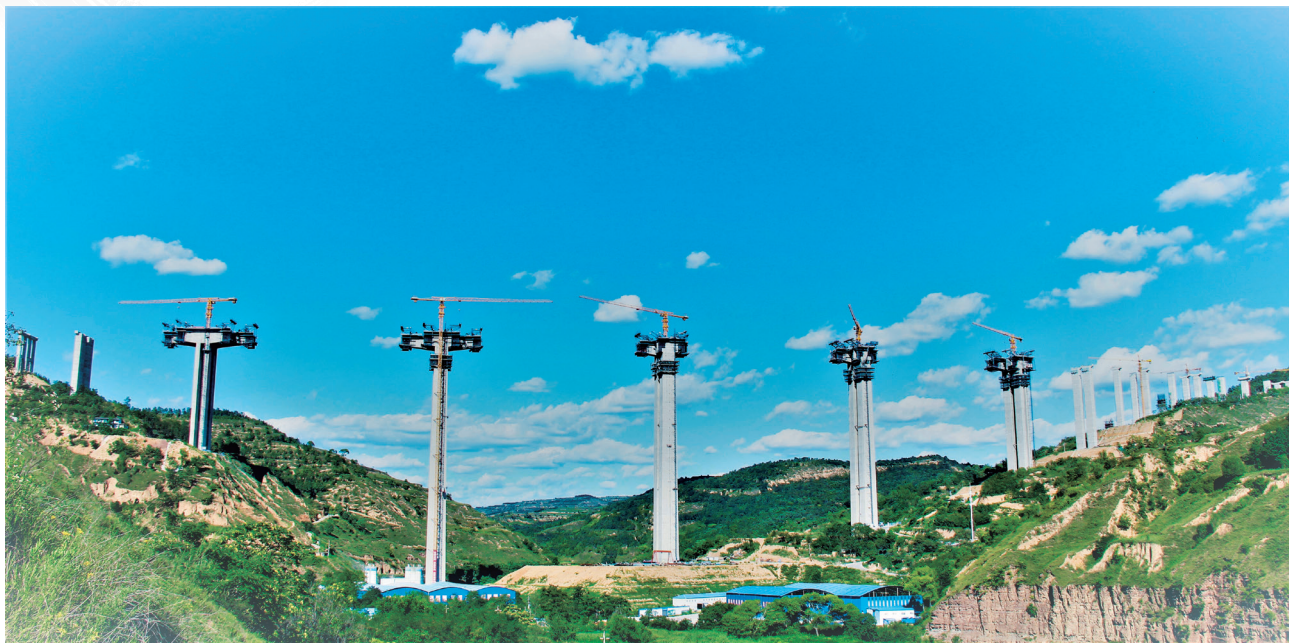
2019年8月12日，由陕西路桥集团承建的旬邑至陕甘界高速公路支党河特大桥挂篮施工现场（陕西路桥集团）
