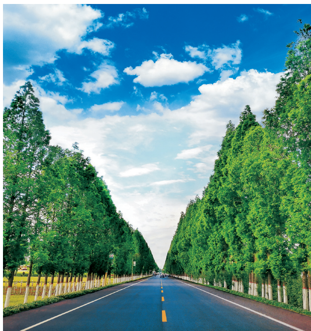
2019年9月，经过大中修工程养护后的西安市鄠邑区甘曹路 (鄠邑公路管理局 张昊)
