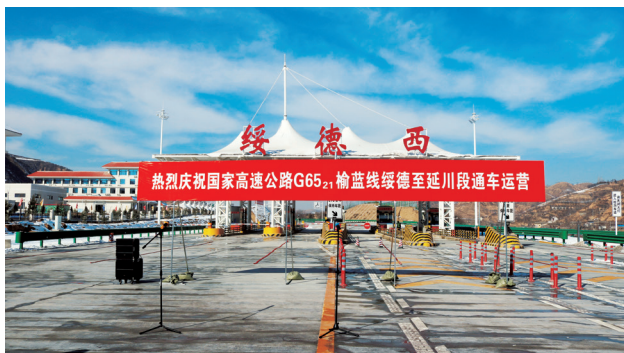
2020 年 1 月 20 日，绥德至延川高速公路建成通车，图为绥德西收费站（榆林市交通运输局）
