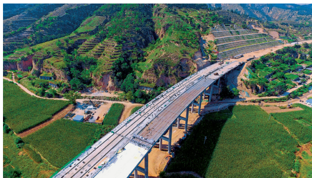
2019 年 8 月, 建设中的延安至子长高速公路高家河特大桥 (省交通集团)
