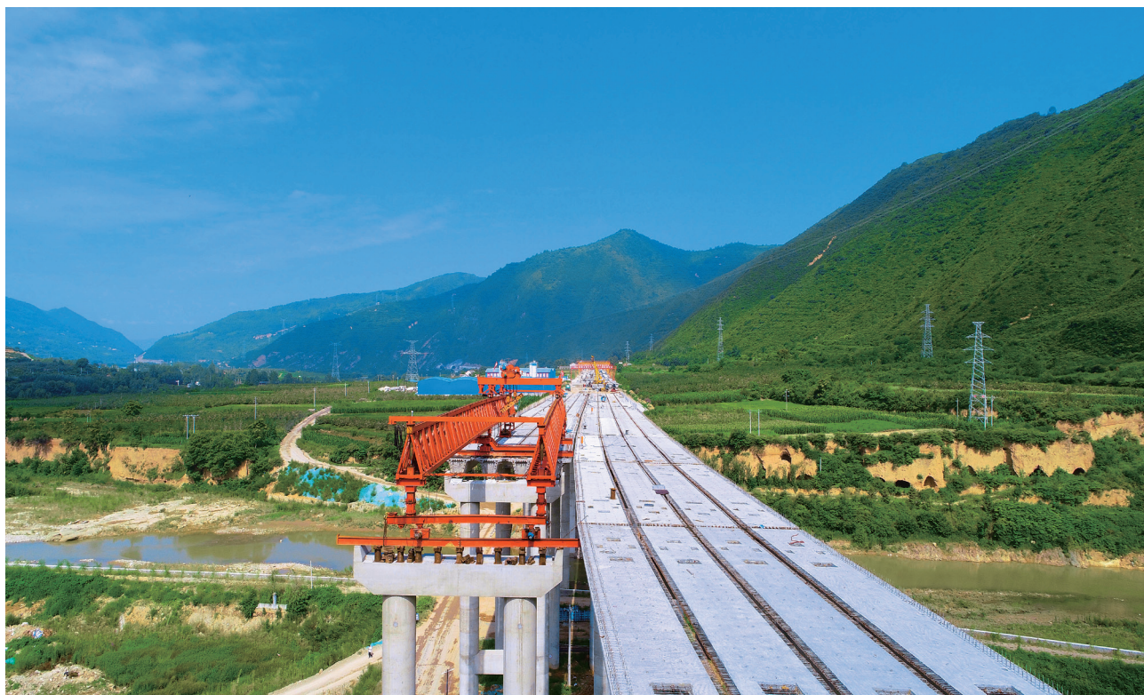
2019 年 7 月 3 日，太凤高速凤州 3# 特大桥梁板架设施工现场（省高速集团）
