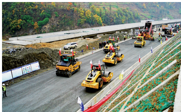
2019 年 12 月 25 日，安岚高速水稳碎石底基层试验段开铺（省高速集团）
