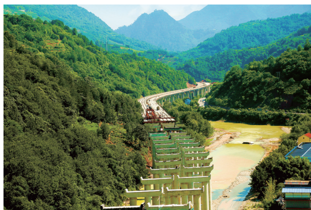
2019 年 7 月 13 日，西镇高速 XZ-02 合同段在建的泾洋河大桥（省高速集团 马蕾）
