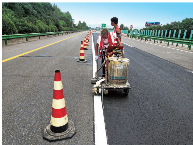
2019 年 7 月 21 日，西宝高速路面养护工程施化标线 (省高速集团)
