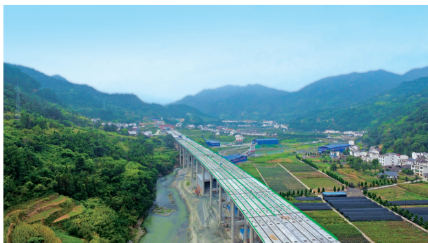
2019 年 10 月, 建设中的平利至镇坪高速公路鸡心岭特大桥 (省交通集团)
