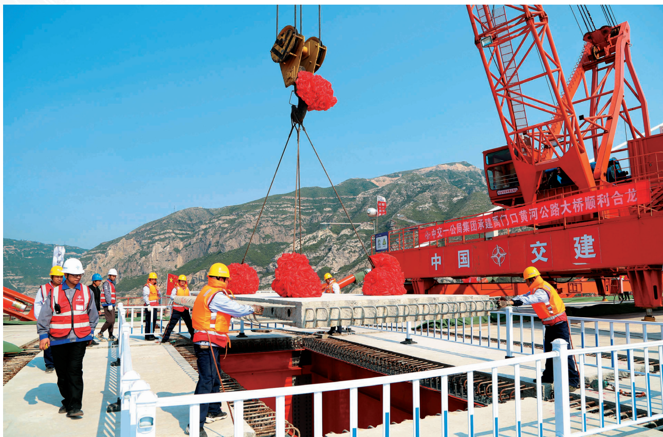
108 国道禹门口黄河公路大桥工程主桥合龙 （史济源）
