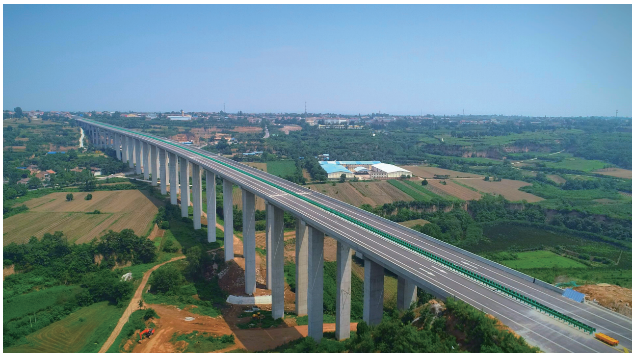
2019年，107省道杨扶眉公路马超岭大桥建成通车（李 聪）
