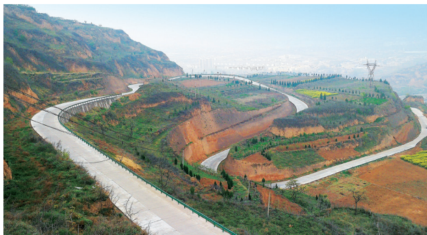
2019 年，渭南市华州区新修建的县道瓜金路（马向飞）
