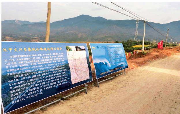
2019年,汉台区文川至褒城公路建设项目现场施工图
