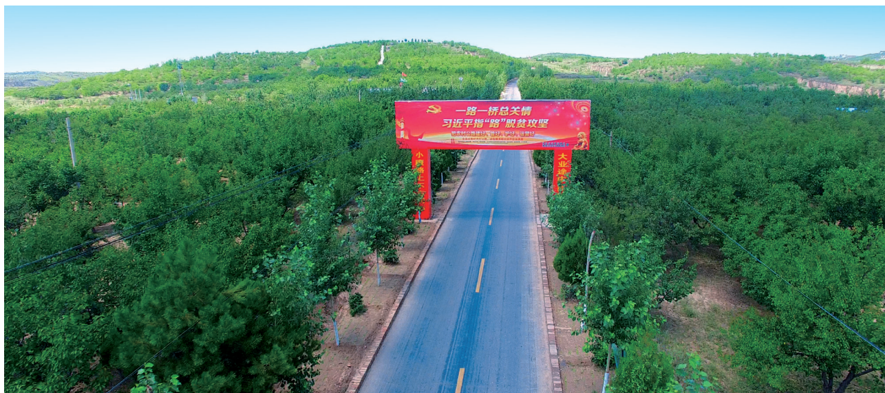
2019 年，榆阳区三鱼路被评为“四好农村路”市级示范路
