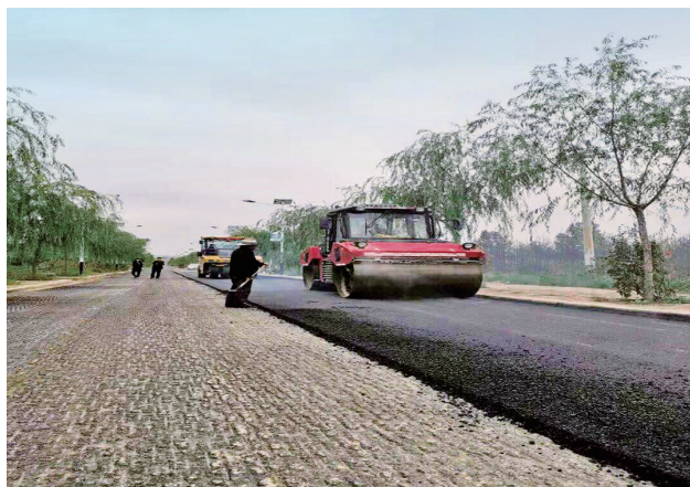
2019年8月15日，靖边县交通运输局工程技术人员在坝九路“油返砂”整治工程现场指导检查沥青混凝土路面施工工作
