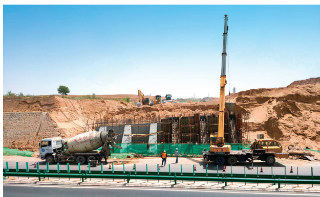
2019年，横山区陕能路兴丰互通立交桥施工现场
