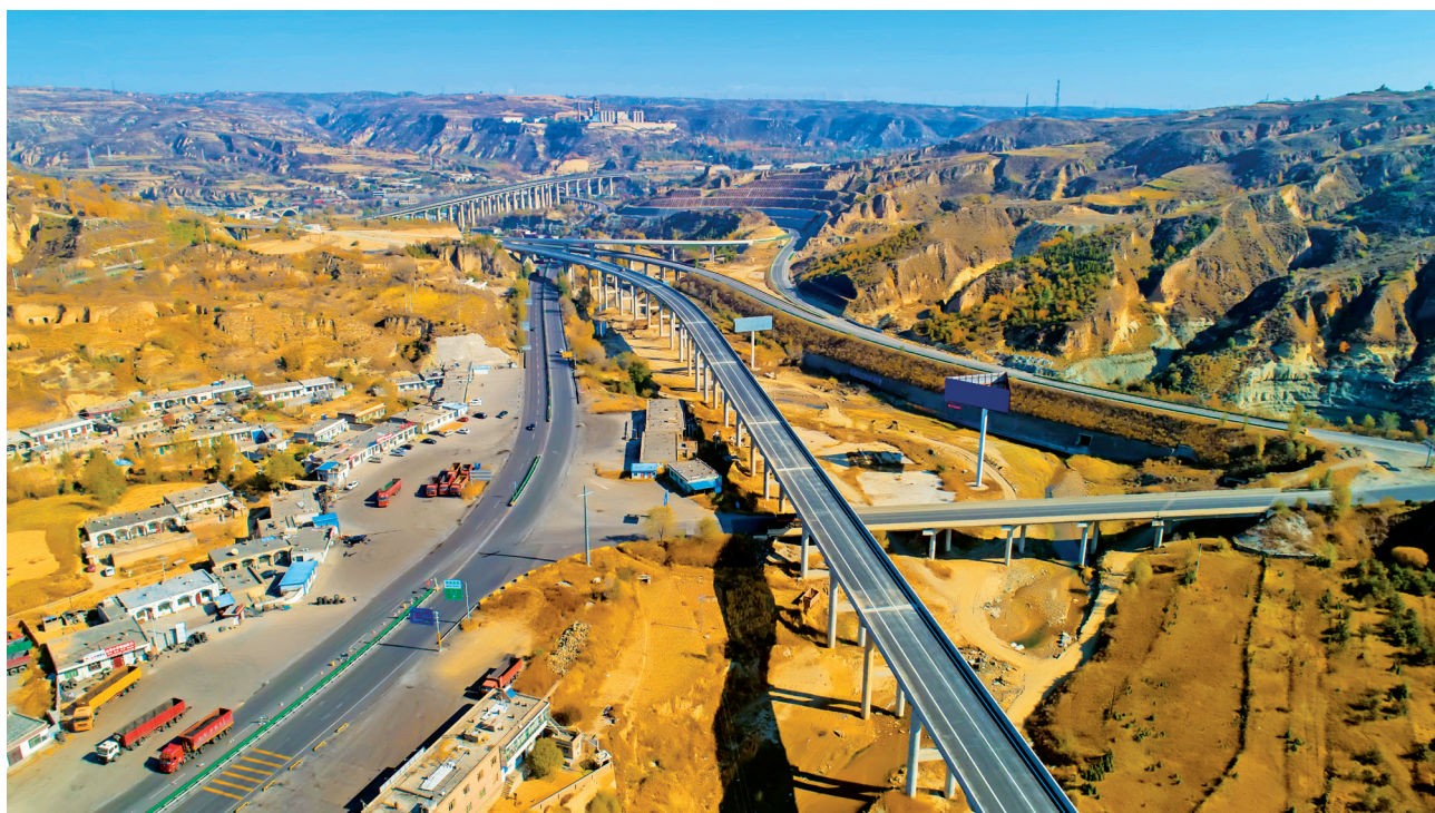
2019年，府谷段大石一级公路野芦沟大桥建成
