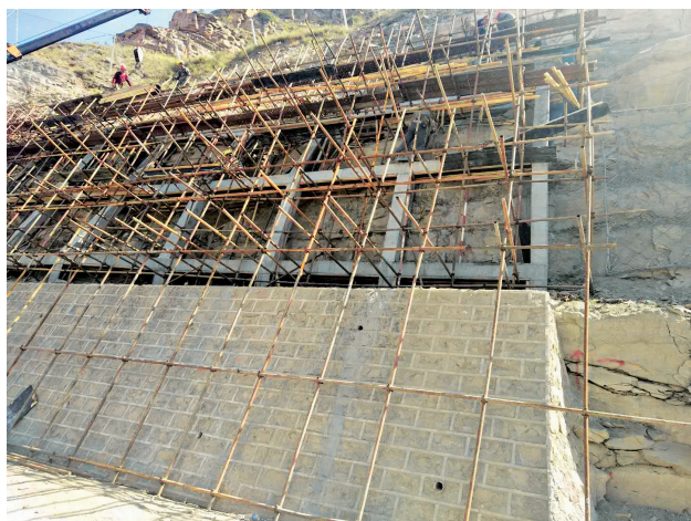
2019年7月2日,佳县沿黄观光路高边坡隐患治理工程进行锚杆框架梁施工
