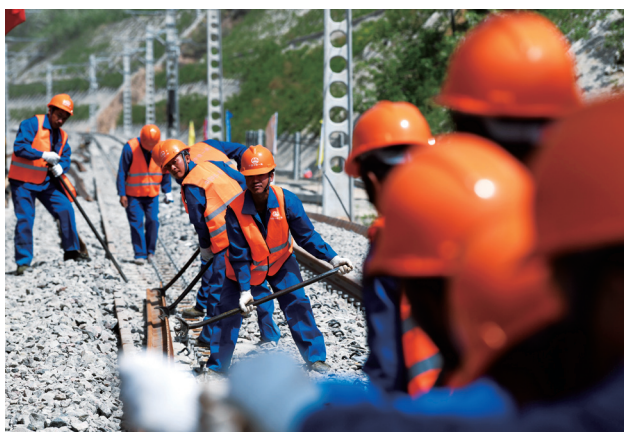
2019 年 5 月 17 日，中铁一局新运公司施工人员在蒙华铁路蒙陕段进行长轨换铺作业 (新华社记者 张博文)
