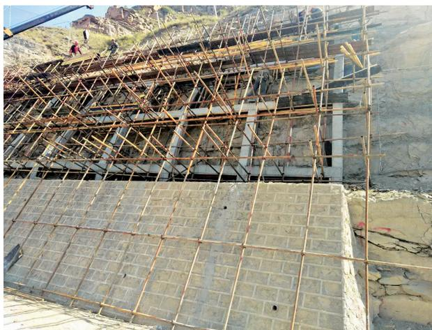
2019年7月2日,佳县沿黄观光路高边坡隐患治理工程进行锚杆框架梁施工
