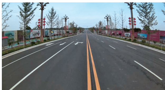
2019 年，临渭区解放路改建项目完工（毋文波）
