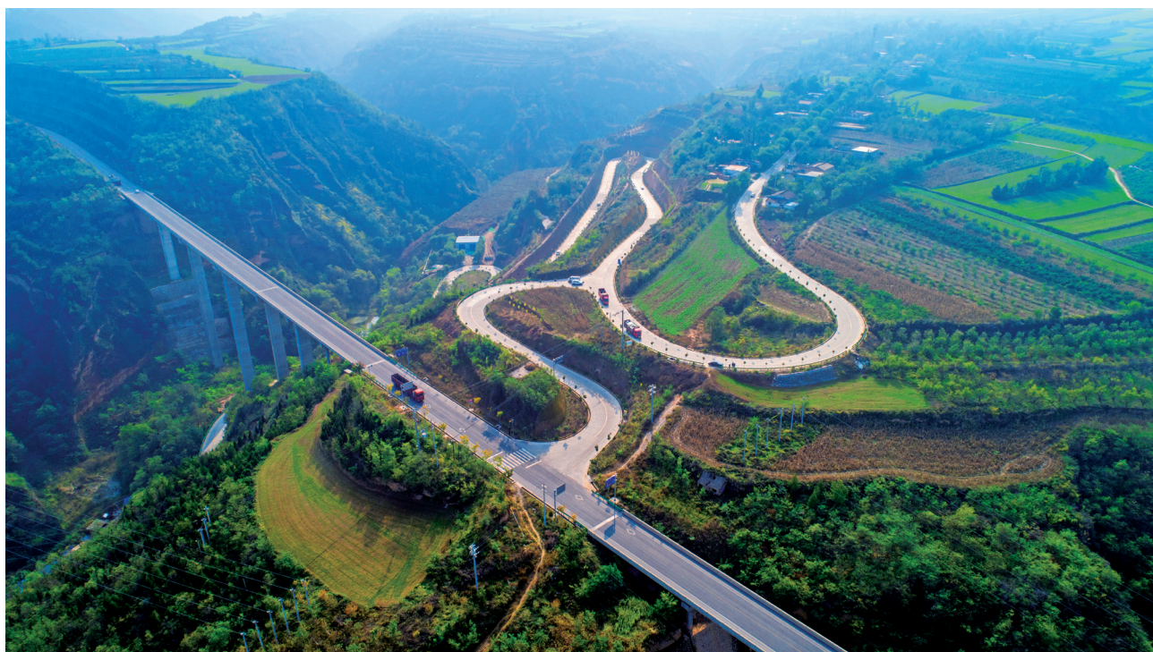
211 国道淳化过境段与重要县镇公路交织互通
