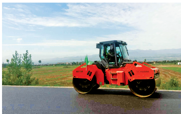
2019 年 7 月 10 日，西宝中线陈仓段油层铺筑现场（李世强）
