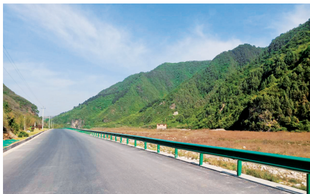
2019 年 10 月 4 日，陇县八渡镇西坡村、东风至县功公路改建工程二标段（张凯轩）
