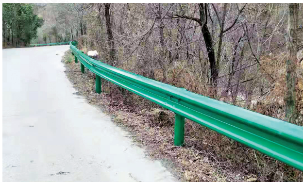
2019年12月13日，凤县酒奠梁至扈家窑段安防工程完工 (杨占宇)
