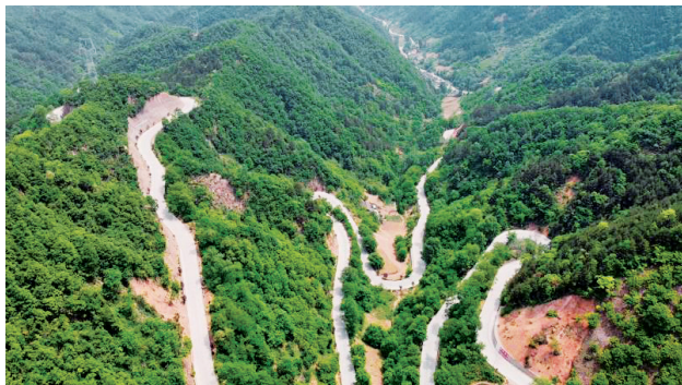
2019 年 5 月，柞水县东红路东坪—蔡玉窑段路面修补后全线通车
