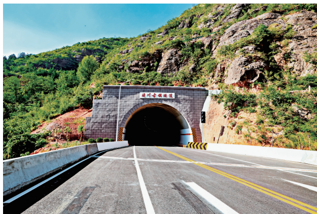
2019 年，山阳县境内漫川古镇过境隧道建成通车
