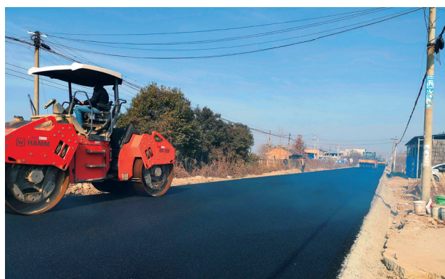
2019 年 12 月 2 日,周至县油鹿路改造工程油面铺设现场
