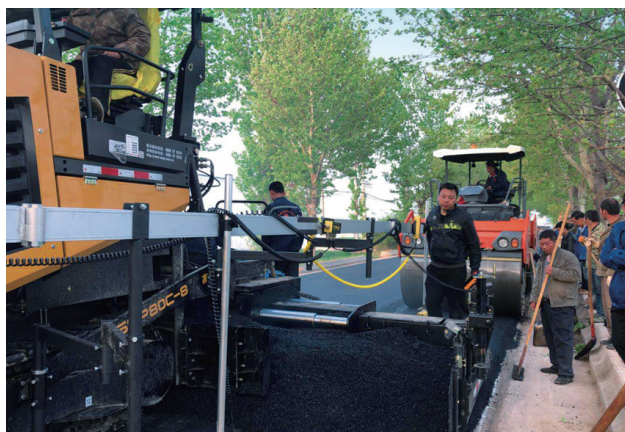
2019年，阎良区阎油路中修项目正在进行油面铺设 (钟万森)
