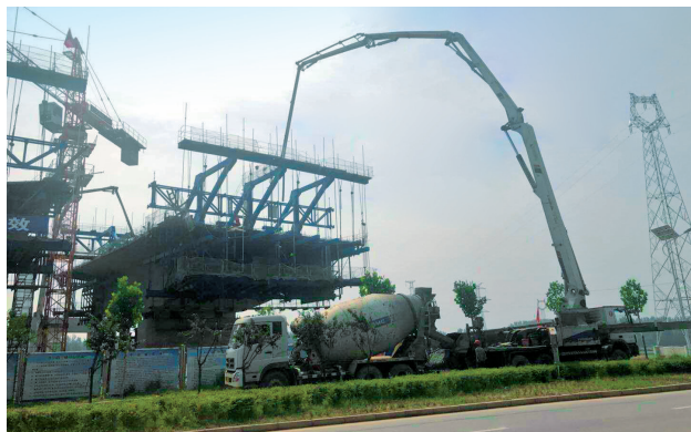
2019 年, 临潼区 310 国道 (渭北大横线) 渭河特大桥跨河堤路桥梁移动模架现场浇筑
