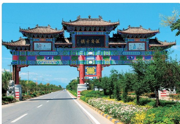
2019 年 7 月，鄂邑区蔡家坡通村路“油返砂”工程完工 (张 昊)
