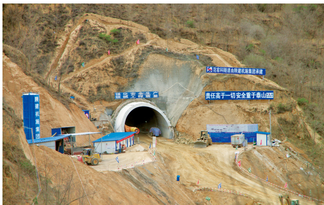
2016年4月6日，宜川县交通运输局承建309国道宜川县城过境路范窑科隧道建设现场
