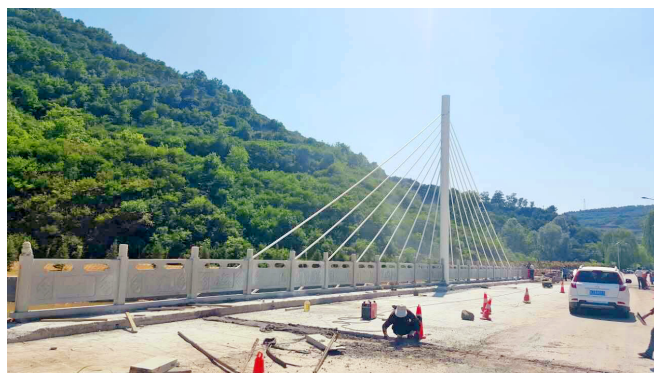
2016 年 7 月，黄龙县交通运输局黄龙景区道路施工现场
