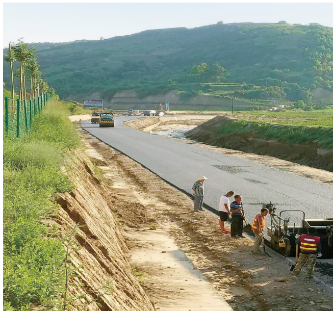
宝塔区交通运输局抓紧万石三级油路工程施工
