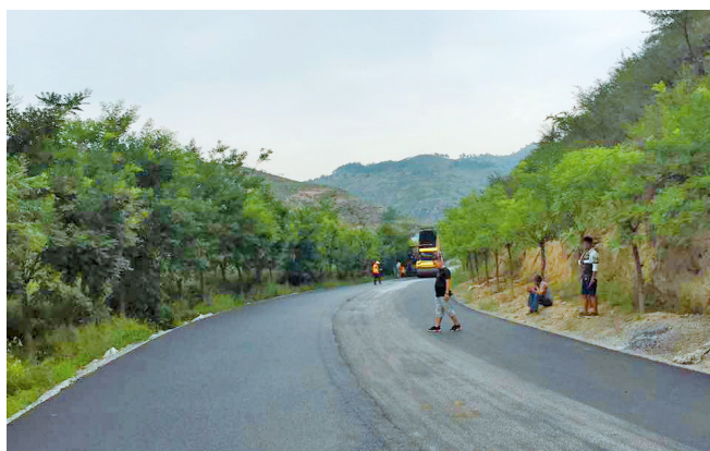
志丹县交通运输局抓紧进行农村公路路面铺筑
