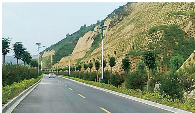
2016 年，安塞县交通运输局修建的老沟岔至南沟三级公路
