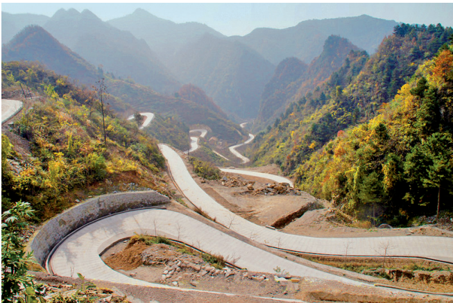
商洛市山阳县黄漫公路鹫岭段改建工程建成通车
