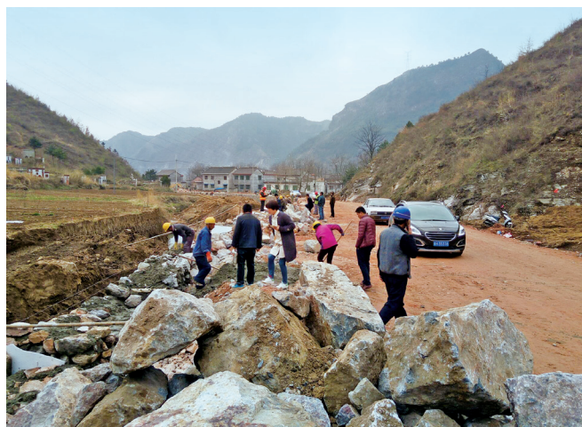
洛南县交通运输局洛瀘路一期工程施工现场
