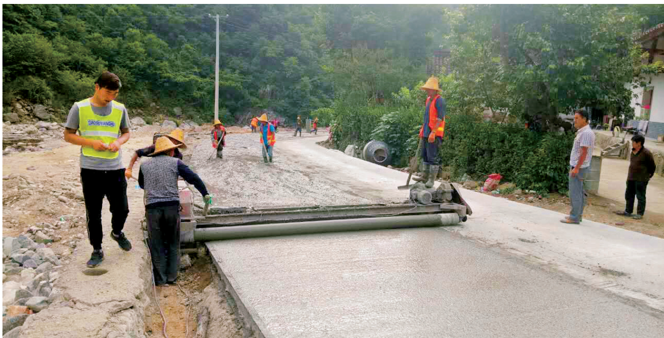
佛坪县吕关河至龙潭子四级公路水毁修复路面铺设现场
