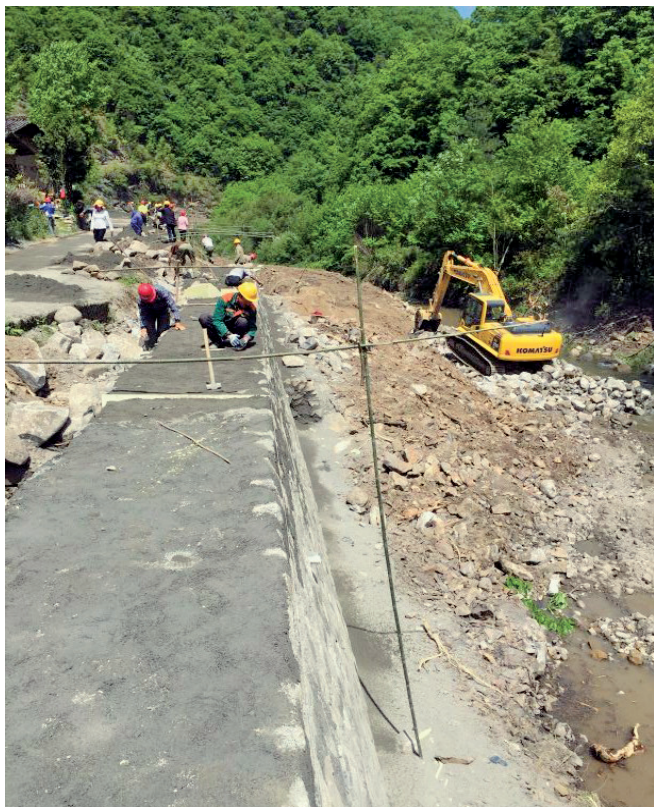
留坝县交通运输局农村公路建设现场
