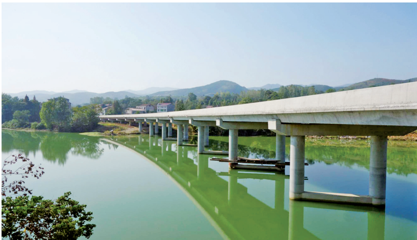
西乡县交通运输局新建成的牧马河青龙大桥
