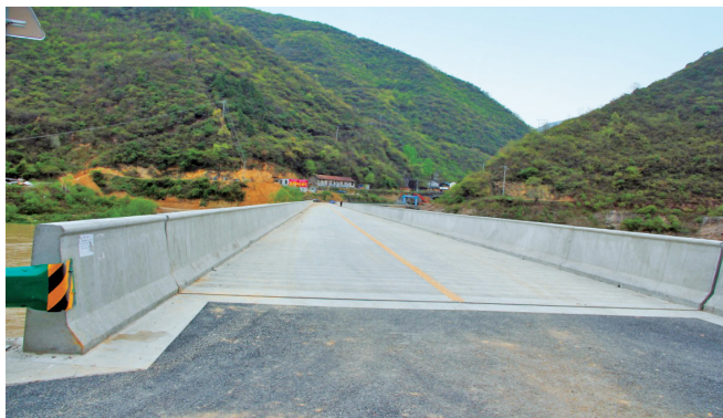
略阳县交通运输局建成的荷叶坝嘉陵江大桥
