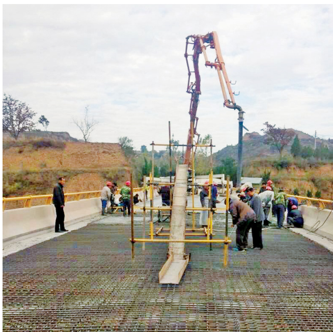
铜川涧沟大桥浇筑铺装层
