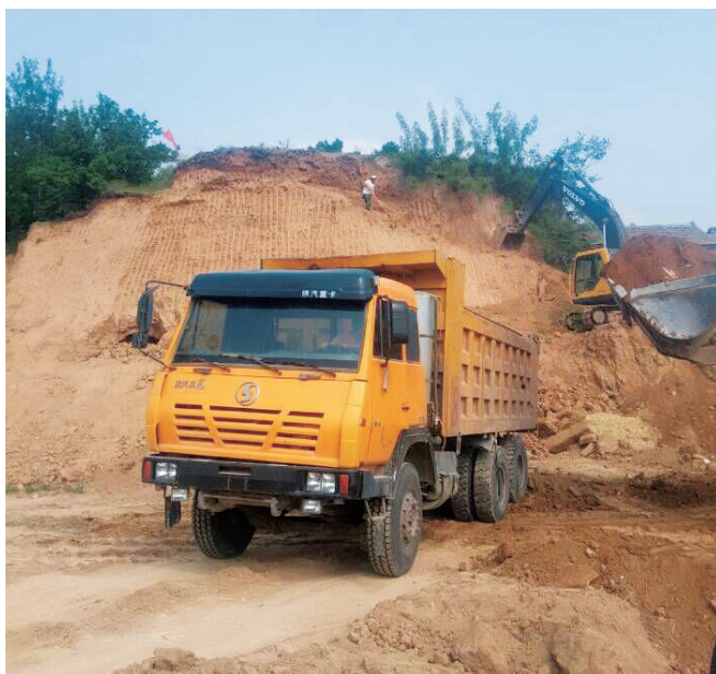
2016 年 6 月, 王益区黄环旅游公路开始施工
