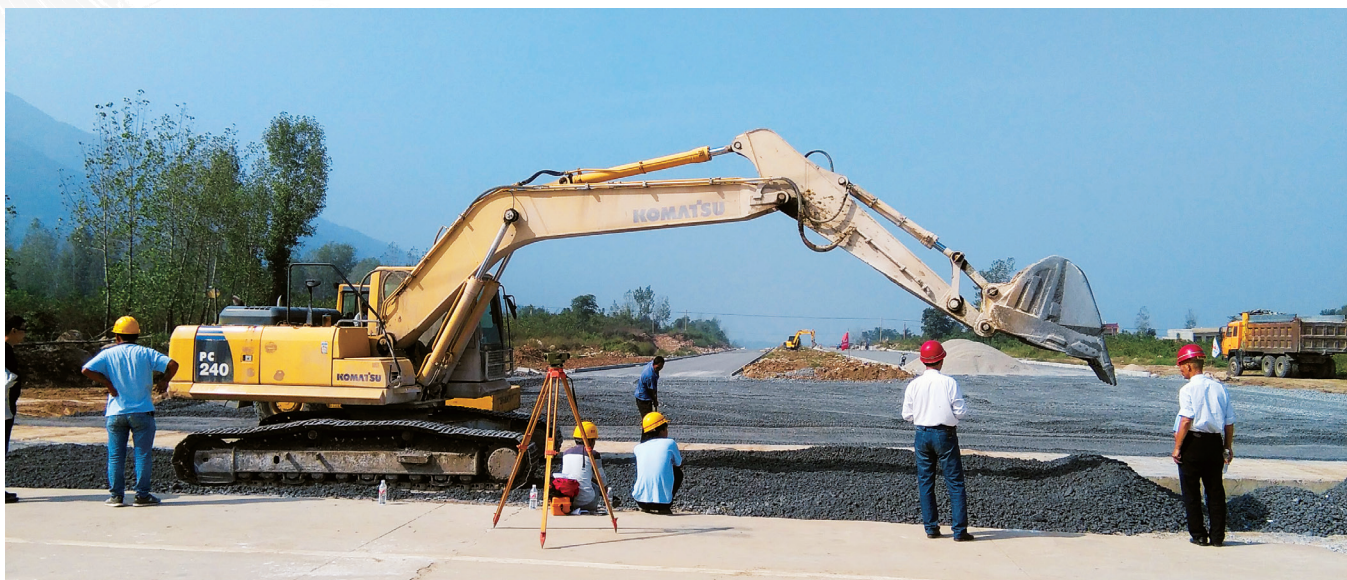
2016年9月22日，华州区环山公路建设现场
