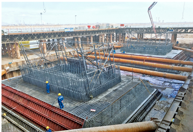
2016年,韩城市交通运输局进行108国道禹门口黄河公路大桥墩柱基础施工
