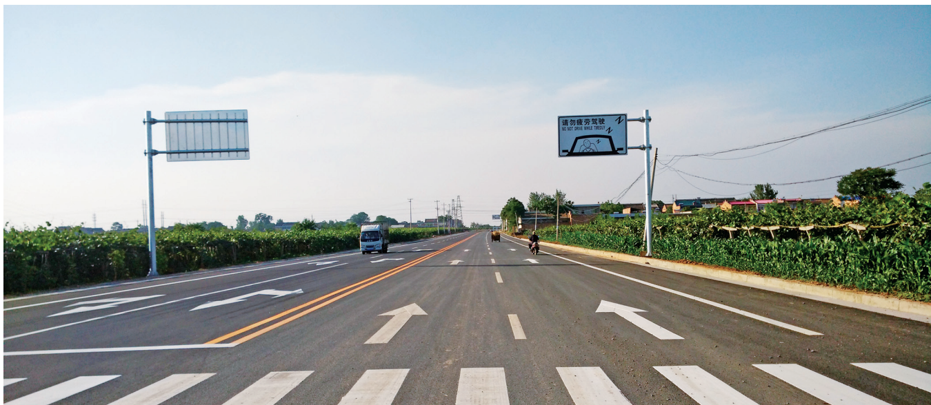
2016 年，杨陵区杨扶路改线工程全线贯通，投入使用
