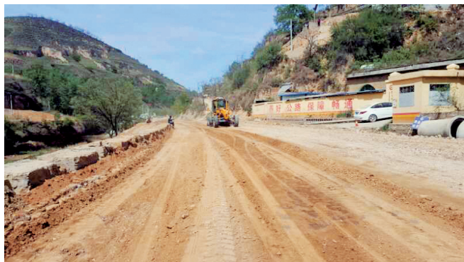
307 省道吴堡至绥德改建工程东段施工
