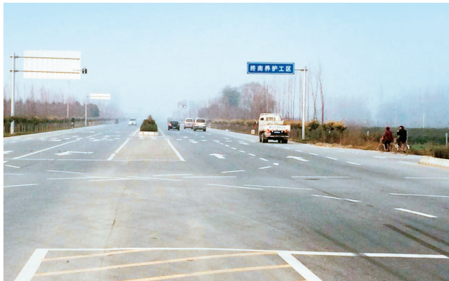
108 国道周至段改扩建工程竣工
