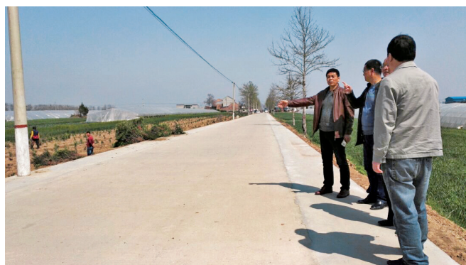
阎良区西老路(村道)加宽改造项目竣工
