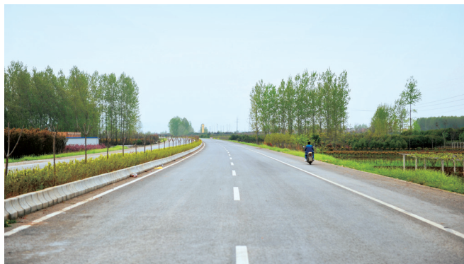
2016年4月16日，108国道周至段改扩建工程竣工
