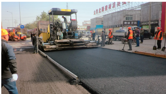
2016年11月11日，未央区交通运输局整治太华北路路面
