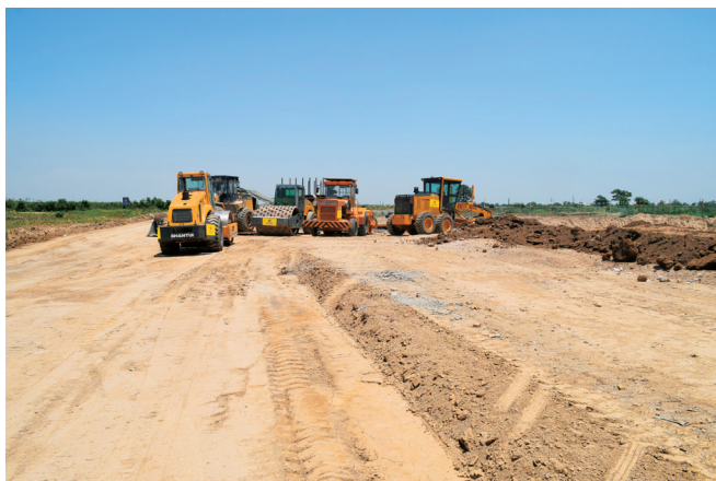
2016 年 6 月 29 日，310 国道任留段路基施工现场
