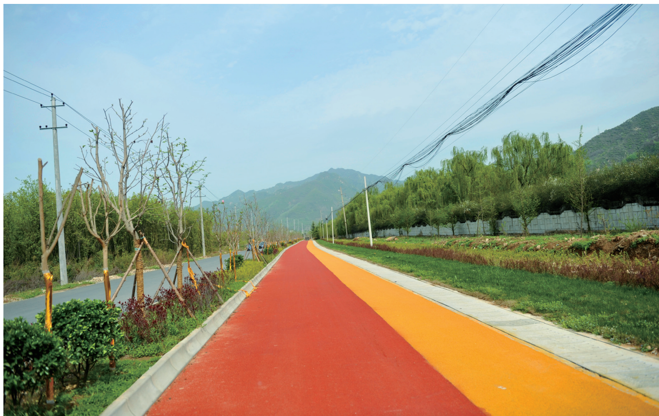
2016年4月7日，秦岭北麓生态旅游绿道工程竣工
