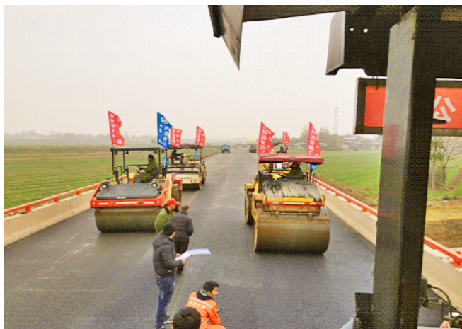
橡胶沥青混合料路面试验段铺筑作业
