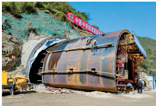
宝坪高速公路二衬台车打模施工作业现场 (李 钢)
