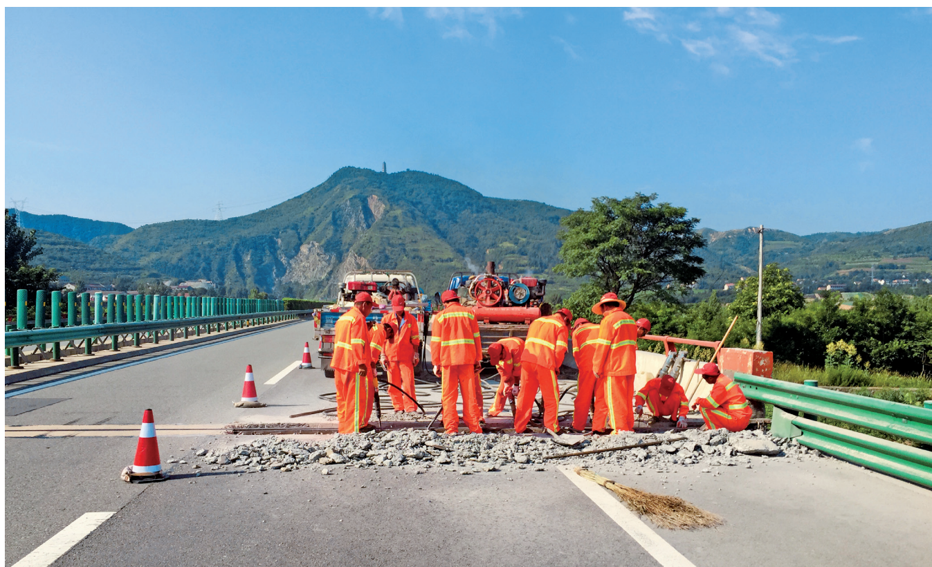
2016 年 7 月 1 日, G70 蓝商高速蓝田段养护工程修复桥梁伸缩缝锚固区 (顾 盼)
