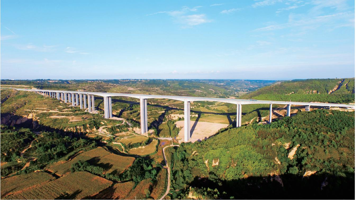
黄（陵）延（安）高速公路淤泥河特大刚构桥，全长 846 米 （黄金峰）
