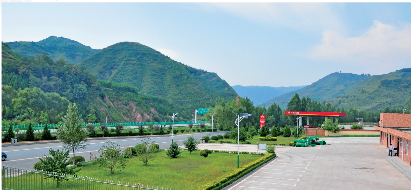
2015年8月28日，212省道火烧寨服务区建成通车使用（宝鸡市交通运输局）
