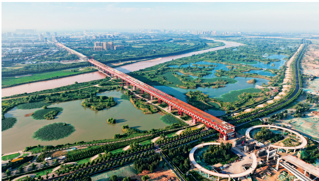
2023 年 8 月 18 日，西安地铁 10 号线一期公轨合建桥合龙（西安市轨道交通集团）
