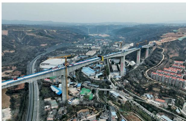
2023年11月15日，西延高铁全线重难点控制性工程——王家河特大桥主桥成功合龙，这是西延高铁全线跨度最大、高度最高的桥梁
