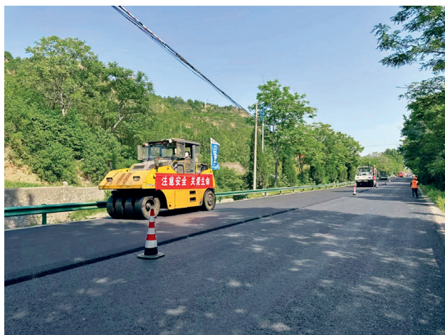
2023 年 5 月，G344 千阳县城至峰山（陕甘界）路面改造工程施工现场（宝鸡市公路局）
