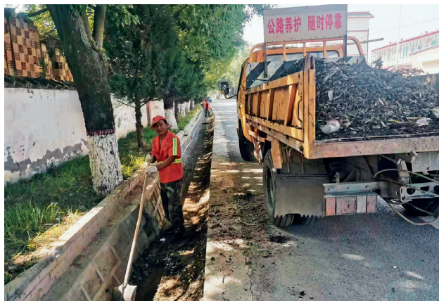
2023 年 6 月，洛川公路段职工日常养护现场 (延安市公路局)
