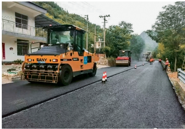
2023年6月15日，汉中市公路局2022年大中修工程留坝G316线完成沥青上面层铺筑，主体工程全面完工 （汉中市公路局）
