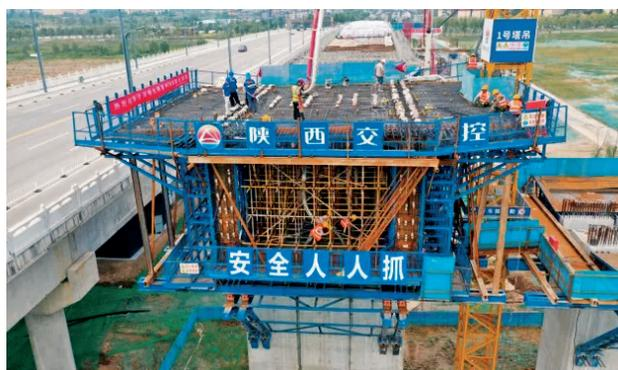
2023年，马家堡至泾阳高速公路项目首个0号块顺利浇筑完成，标志着马泾项目桥梁上部结构施工全面开始（陕西交控集团铜马管理处）
