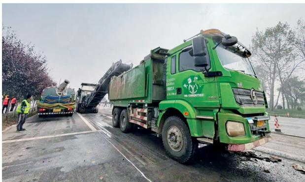
2023年10月，西安市公路局在G310高陵段进行中修及预防性养护工程中，利用新技术，为无明显病害的路面铺筑纤维微表处，起到封水作用，为道路穿上一件“雨衣”，进行预防性养护（西安市公路局）
