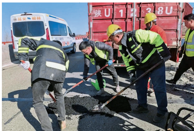
2023年11月，榆靖分公司联合商漫分公司积极推广沥青路面坑槽冷补新技术，取得良好效果 （陕西交控集团榆靖分公司）
