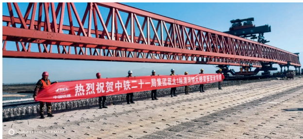
2023 年 6 月 16 日，由中国铁建投资集团投资建设、中铁二十一局负责施工的眉太高速公路控制性工程——渭河特大桥实现双幅贯通
