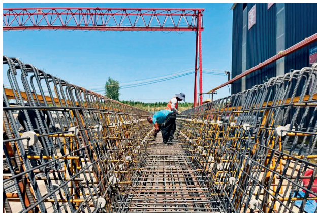
G5 京昆高速蒲城—涝峪段改扩建工程施工现场
