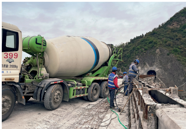
2023 年，G211 旬阳过境线项目加快建设进度，工程完成总项目的 70% （旬阳市交通运输局）
