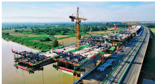
2023年9月，G5京昆高速蒲城—涝峪段改扩建工程桥梁施工现场
