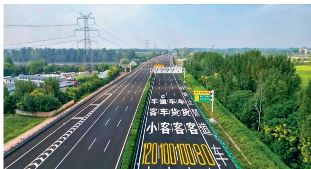
2023年9月，G5京昆高速蒲城—涝峪段改扩建工程建成通车
