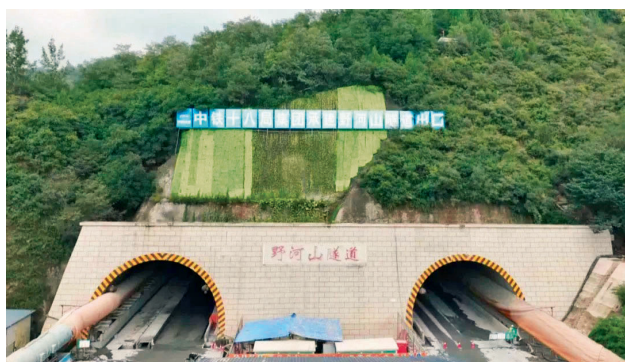
2023年9月，麟法高速公路野河山隧道出口双线掘进突破6000米，施工生产全面进入新阶段 (宝鸡市交通运输局)
