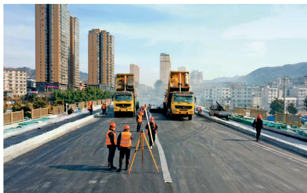
2023 年 3 月 17 日，平利县西大桥拆除重建项目施工现场（陈本利）
