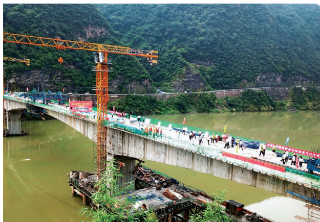
2023 年 7 月 29 日，旬阳棕溪汉江大桥顺利合龙，标志着大桥主体结构即将完工，为实现全桥按期通车奠定坚实基础（旬阳市交通运输局）
