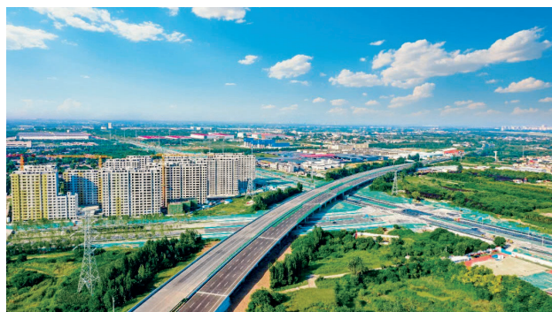
2023 年 9 月，G5 京昆高速蒲城—涝峪段改扩建工程建成通车
