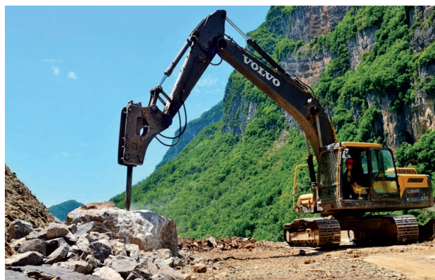
2023年，宁强县农村公路建设施工现场
