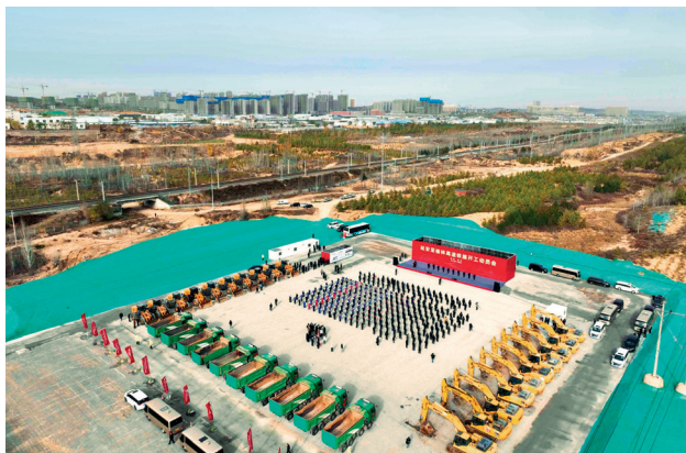
2023年11月5日，延安至榆林高速铁路正式开工
