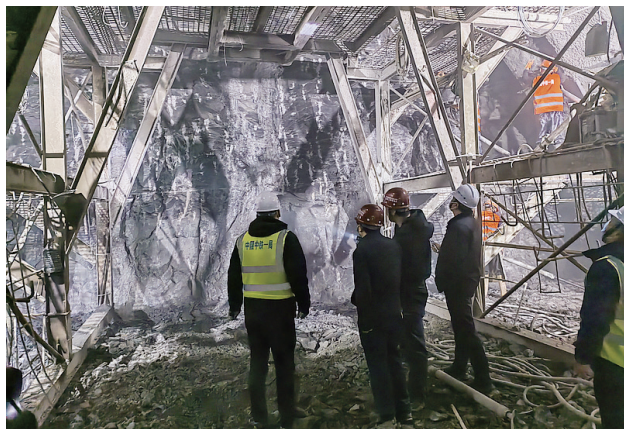
2023年2月,242国道黄龙县城过境公路龙尾湾隧道施工建设现场
