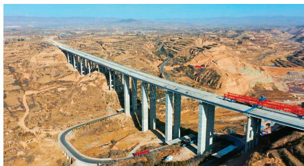
2023 年，渭南市澄城县长宁河大桥施工现场
