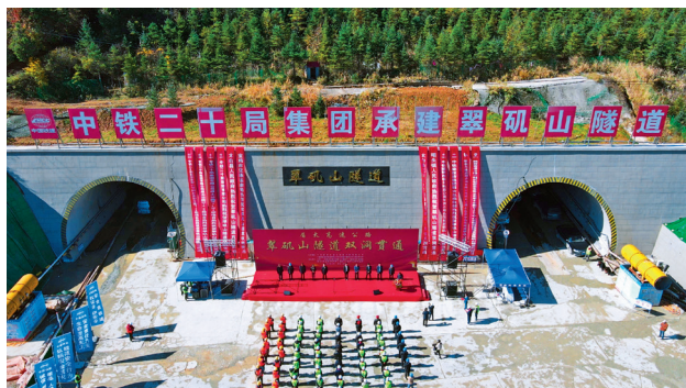
2023年10月20日，眉太高速翠砭山隧道双洞顺利贯通
