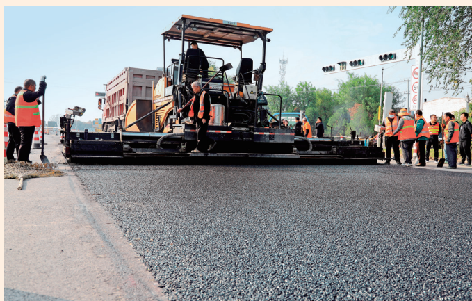
2023年，大孔隙碎石摊铺施工现场
