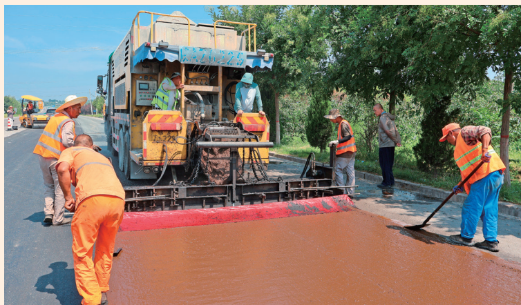
2023年，嵌入式磨耗层施工现场
