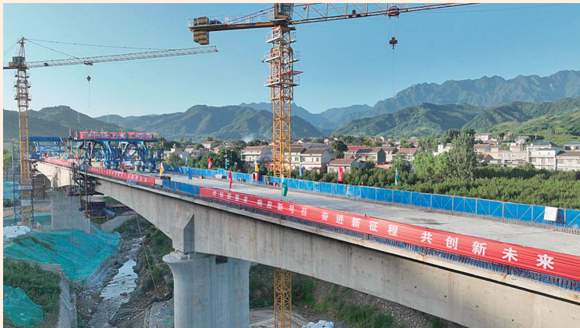
2023年7月8日，西安至十堰高铁岱峪河2号特大桥连续梁完成主体工程施工
