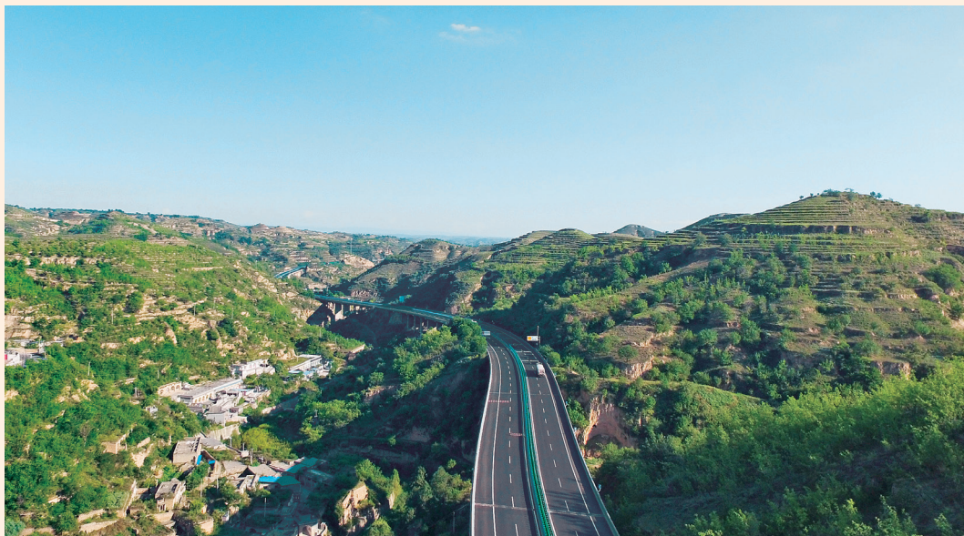
2023年9月2日，交通运输部国家公路现代养护工程试点，G20青银高速公路吴堡—绥德段专项维修整治工程通过交工验收
