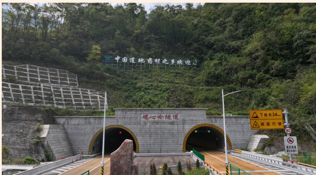
2023年，巫溪至镇坪高速公路陕渝界鸡心岭隧道
