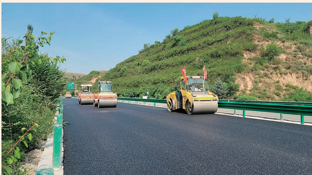
2023年，G20青银高速吴堡至绥德段专项维修整治工程路面摊铺施工现场
