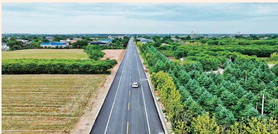
2023年7月31日,S311富平至张桥公路改扩建项目建成通车
