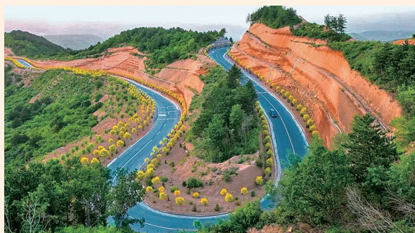
延安市宜川县风马路
