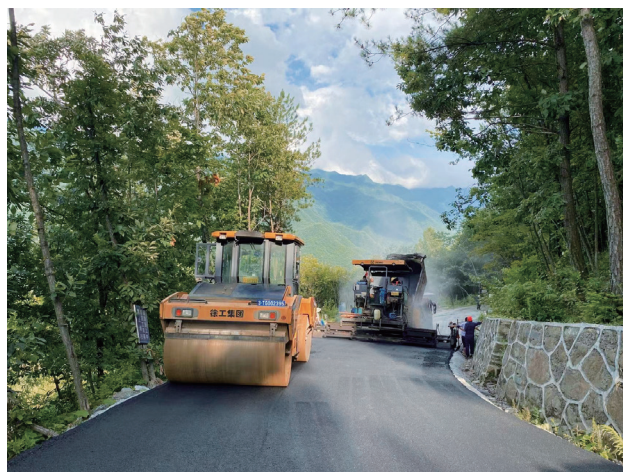
2023年7月31日，镇坪县城关镇友谊村2组通组路沥青路面铺设
