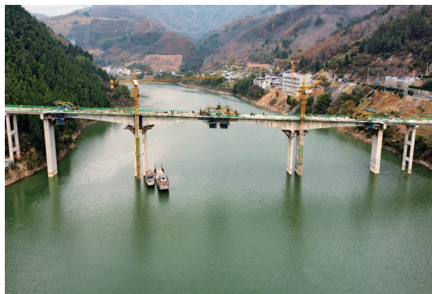
2023年11月30日，紫阳县汉王跨汉江大桥合龙
