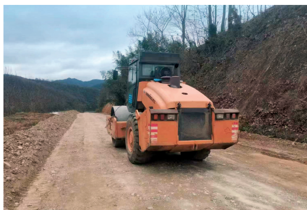
2023 年，洋县黄渭路施工现场
