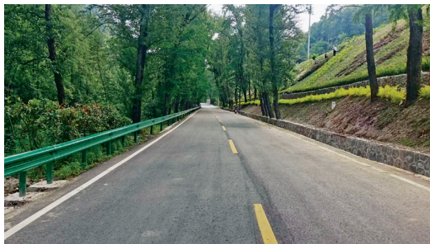
2023年11月，宁强县烈金坝至阳平关公路改建工程建成投用
