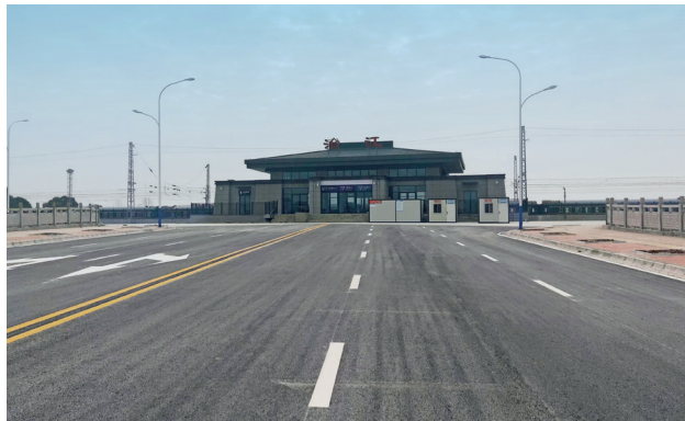
2023 年，城固县治江车站东枢纽项目
