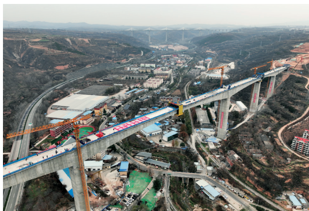
2023 年，铜川市王益区做好西延高铁环境保障工作，确保全线跨度最大桥王家河特大桥顺利合龙
