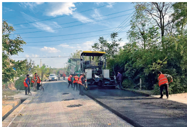
2023 年，千阳县陇千南线改造提升施工现场
