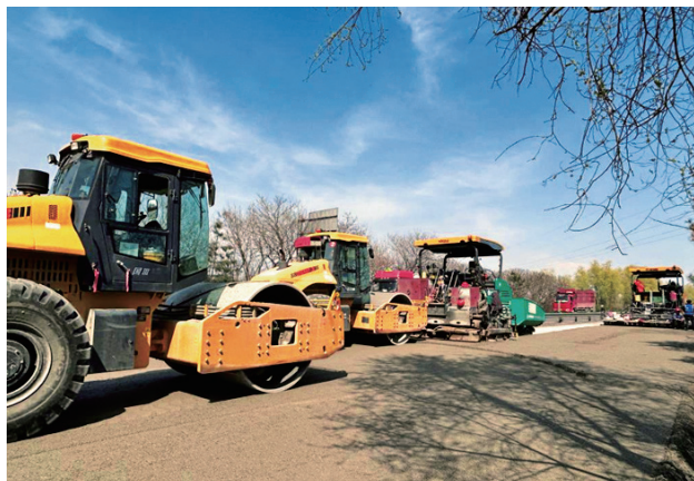
2023年4月，宝鸡市凤翔区西府大道采用水稳冷再生施工工艺改造项目
