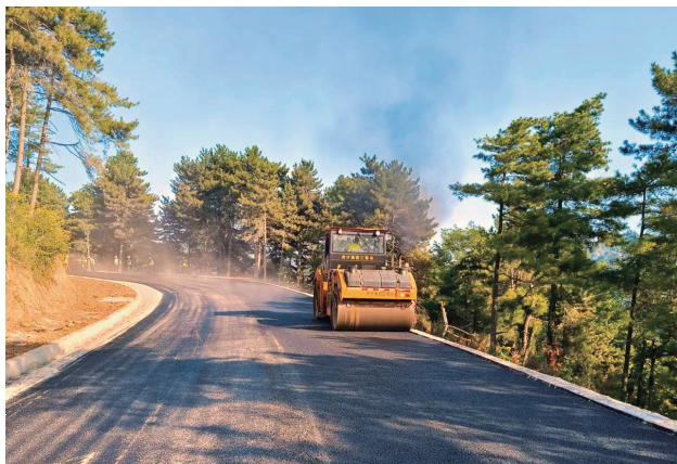
2023 年 8 月 10 日，宝鸡市陈仓区 X306 县功至香泉公路香泉段施工现场
