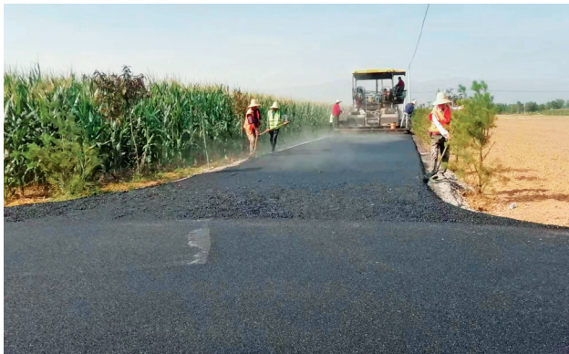
2023 年 9 月 13 日，岐山县公路养护沥青混凝土路面铺装现场
