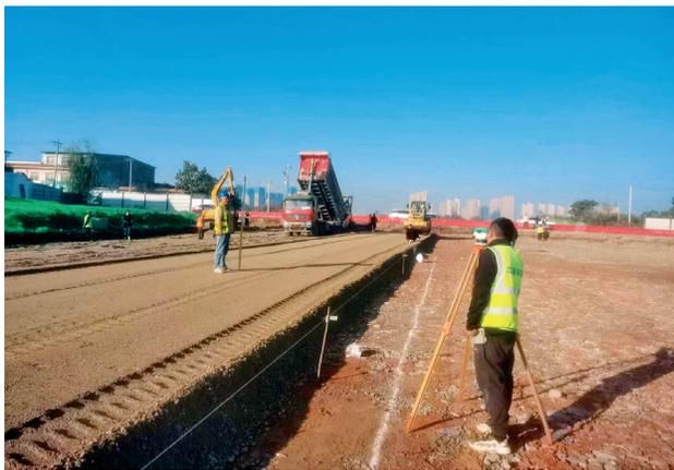
2023 年 11 月 1 日，西安市高陵区徐船路改建工程水泥稳定碎石基层摊铺施工现场
